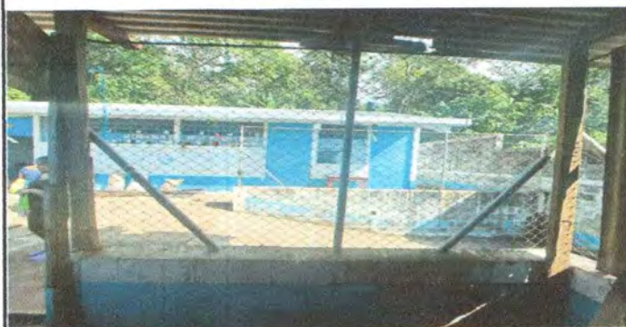
Foto 7: Sustrucion de estructura de metal por ventana
