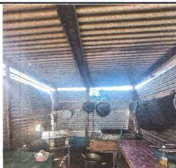
Foto 5: Instalación y sustitución de la red de electricidad
