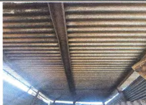
Foto 4: Sustitución de techo de lamina por lamina troquelada aluzinc
