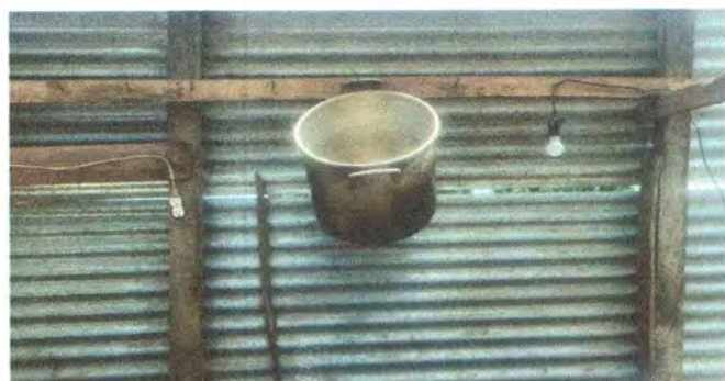
Foto 9: Reparación de Sistema Eléctrico
