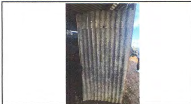
Foto1: Sustitución de puerta de metal
