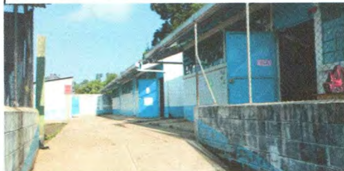
Foto 10: Pintura en muros interiores y exteriores
